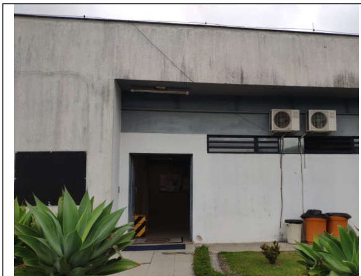
Foto 32 - Porta metálica a ser substituída por portas corta-fogo (fachada posterior)
