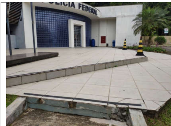
Foto 29 - Revestimento cerâmica da calçada principal a ser removido e substituído
