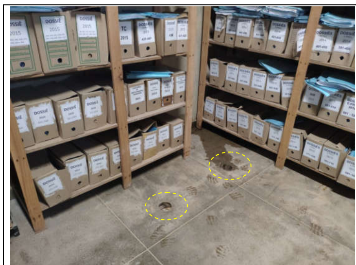
Foto 6 - Vista dos pontos no piso a serem tratados e instaladas grelhas para ralos sifonados no depósito (círculos amarelos).
