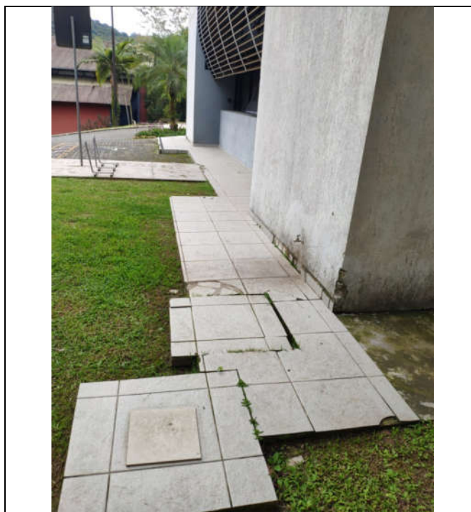
Foto 31 - Revestimento cerâmica da calçada principal a ser removido e substituído
